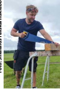
Filip Axelsson bygger altan.
