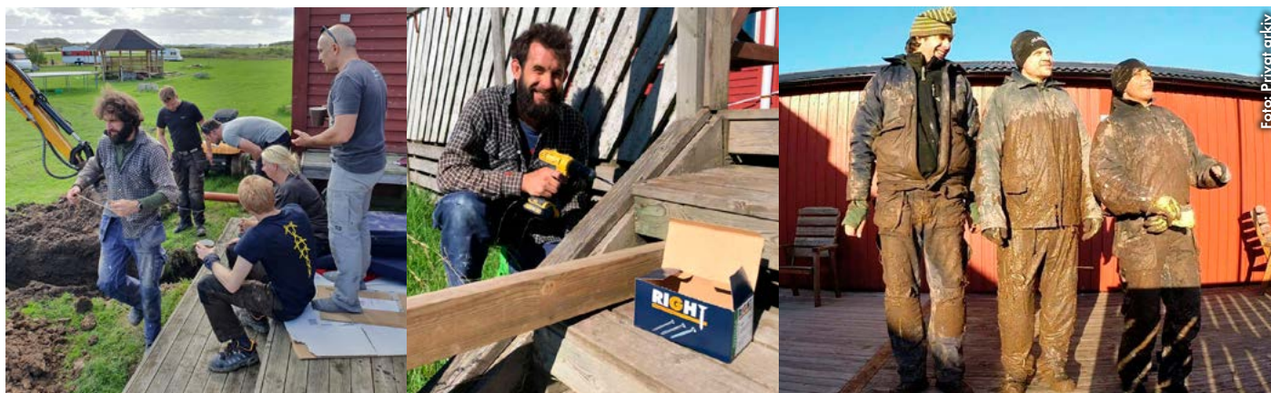
Dränering framför klubbhuset i Vårgårda, Peter som lagar en trappa och ja Ola, vad händer egentligen på bild nummer tre? "På den bilden så har vi varit under klubbstugan och satt upp balkar för att golvet sviktade och det var ett riktigt skitjobb.. Men nu sviktat inte golvet längre!" berättar Ola Johansson om hans, Peters och Michel "Paprika" Salomonssons äventyr under klubbstugan.
